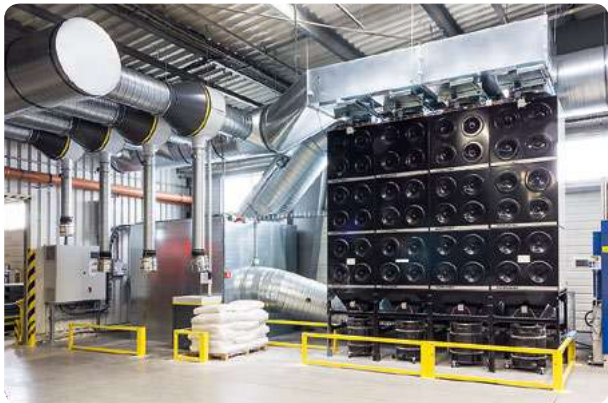
odsávací a filtrační jednotka svařovny
