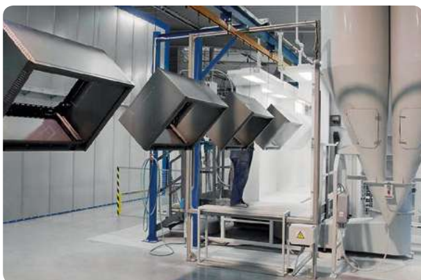
automatizovaný stříkací box práškové lakovny
